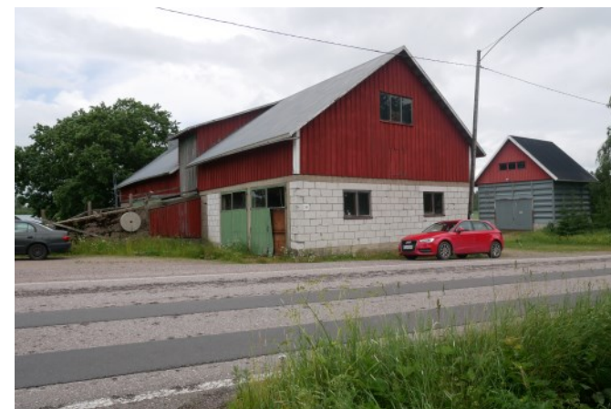
Piltars (8) sannolikt under perioden 1930-1950-talet uppförda ladugård, vars ytterväggar delvis består av cementmursten. (A22)
