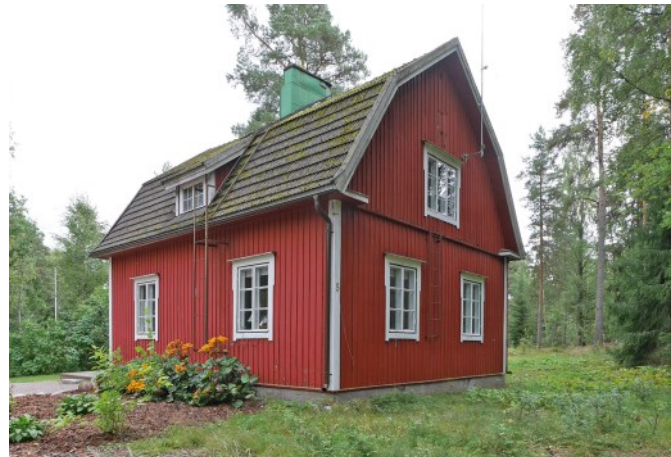
Oskarshamn (106). Boningshus från tidigt 1900-tal med bruttak, vars karaktär i någon mån har förändrats genom tillbyggnader. Byggnaden har betongsockel, fasadbeklädnad av rödfärgad äldre lockläktpanel och kittade fönster av trä. Taket är lagt med cementtakpannor.
