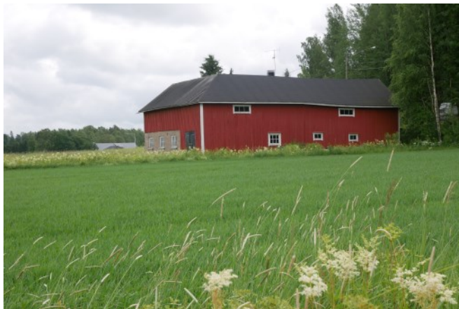
Norråkers (12) i början av 1900-talet uppförda ekonomibyggnad på ett småbruk, med en ladugårdsflygel och ekonomibyggnadsflygel som byggts ihop under samma tak.
