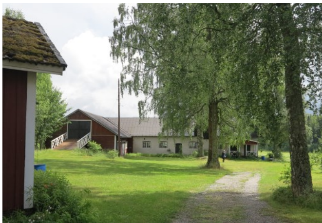
Lövgårds (19) ladugård är byggd av stock och cementmursten. I gaveln leder en körbro upp till vinden. (A21)
