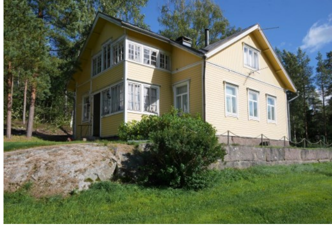
Henriksberg (114). Gammal bostadsbyggnad av villakarakter med glasverandor, tillbyggd i ett senare skede, synligt belägen vid byvägen och ett karakteristiskt inslag i bytomtens landskapshelhet. Fasaderna på byggnaden, som står på en grund av kilad sten, är klädda med hålkålsspontpanel som har förnyats, de förnyade fönstren är utvändigt av aluminium. Förstugan har bevarade äldre fönster.(A41)
