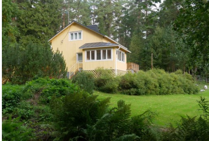
Nestorvik (129). Bostadsbyggnad från återuppbyggnadstiden med typhusprägel och väl bibehållna ursprungliga karaktärsdrag. I hörnet mot havet finns en glasveranda med valmat tak och bredvid den en nyare terrass. Fasaderna har ursprunglig, gul lockläktpanel och ursprungliga fönster.(A42)
