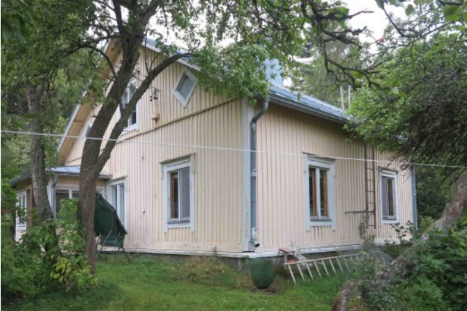
Flätbacka (131). Bostadsbyggnad från 1920-talet med sockel av kilad sten, stockstomme och sadeltak. År 1952 breddades byggnaden med en tillbyggnad med regelstomme och i anslutning till den byggdes en förstuga med valmat tak. Byggnadens nuvarande utseende härrör från 1950-talsskedet.
