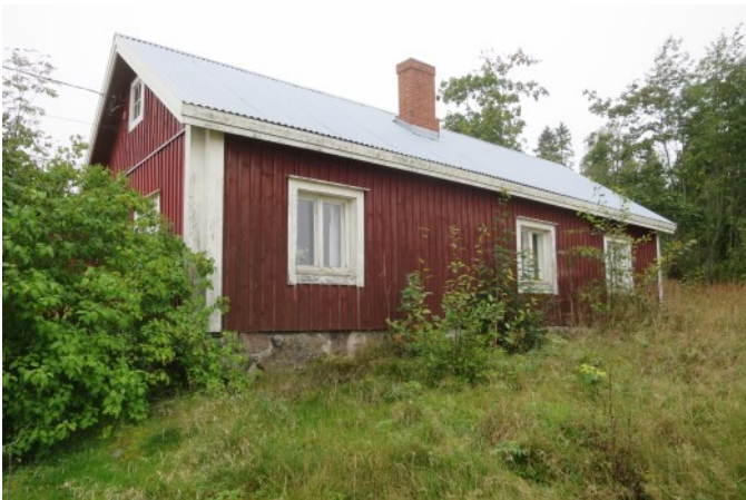
Sandkulla (132). På gårdstunets norra sida finns en bostadsbyggnad med sockel av natursten. Den timrade byggnaden med långa knutar torde härstamma från 1800-talet och har möjligen flyttats senare till sin nuvarande plats. (A38)
