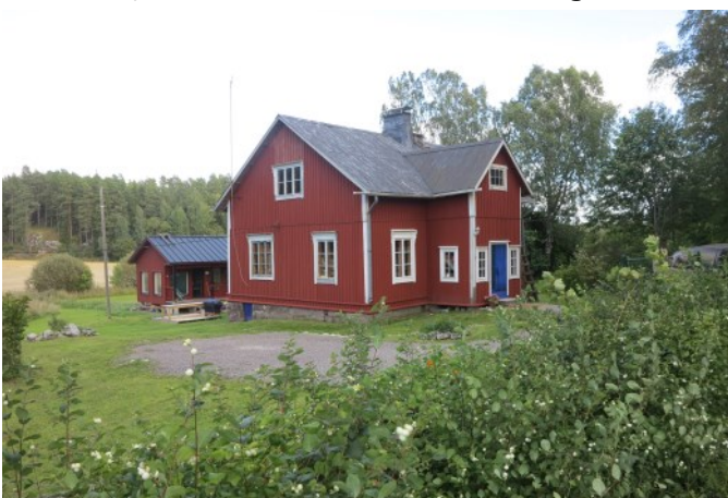
Lindkulla (121). Boningshuset från början av 1900-talet har ett synligt läge i landskapet och dess ursprungliga drag är väl bevarade. Byggnaden har sockel av kilad sten, sadeltak och en hög förstuga med trappa till övervåningen. Fasaderna är klädda med röd lockläktpanel, de 6-rutade fönstren har kittade glas.
