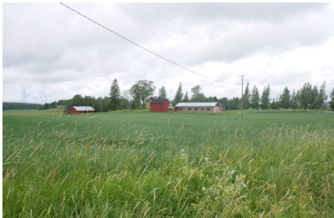
Stens f.d. fräsehemmans gårdscentrum (6) har åtminstone sedan 1600-talet haft ett framträdande läge i kanten av den stora odlingsslätten. Byggnaderna kantar gårdskullen och solitärträdens kronor framträder tydligt i landskapet. (A23)
