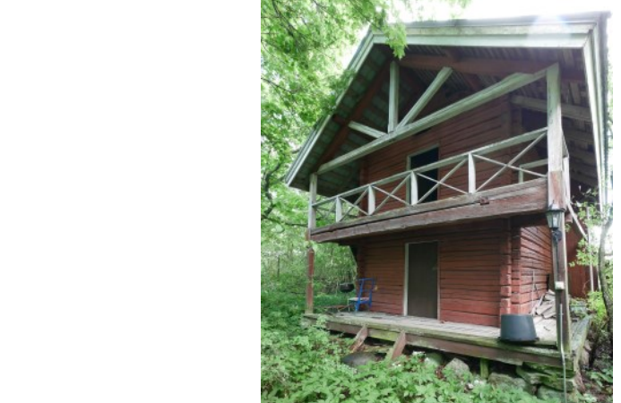
Snickars (21) gamla knuttimrade loftbod, vars utskjutande tak bärs upp av en präktig fackverkskonstruktion. (A24)
