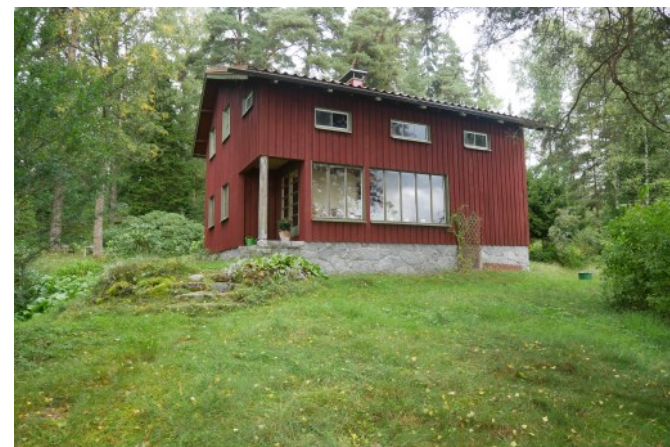
Suviniemi (122). Fritidsbyggnad med asymmetriskt sadeltak, en indragen veranda och genomtänkta detaljer. Fasadmaterialet är röd lockpanel, fönstren är av trä, mestadels med fyra rutor, ett större fönster har vertikal indelning.
