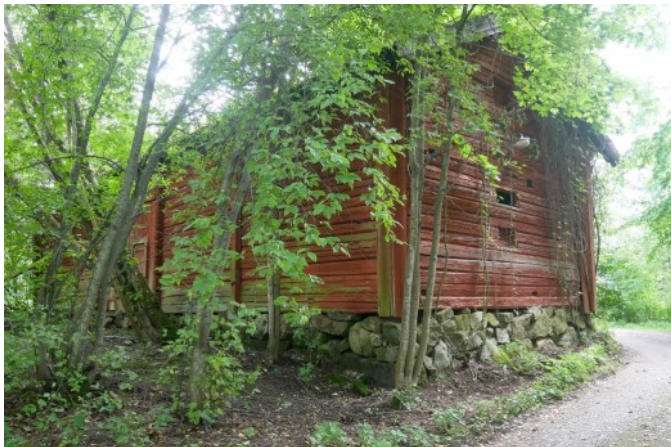
Storbengts (83). Ett av byns stomhemman och ett f.d. skatterusthåll, ett i flera delar timrat boningshus med långa knutar, som har bibehållit sitt traditionella utseende, och en stor gammal knuttimrad ekonomibyggnad som har haft en port i mitten. (A32)
