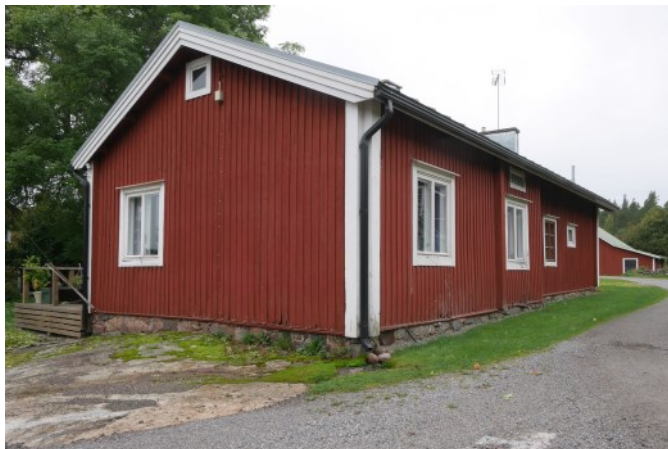
Bergkulla (142) ligger på platsen för Överkärras stomhemmans ursprungliga gårdscentrum. I gårdstunets södra kant finns en gammal, timrad bostadsbyggnad med långa knutar och låg sockel av kilad sten, senare förlängd och förändrad. (A39)
