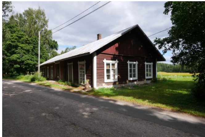
Snickars forna gårdscentrums område breder ut sig på båda sidor om byvägen. Till gårdens mångsidiga näringsfång har bl.a. hört en såg. Vid vägen finns en bevarad långsträckt, knuttimrad ekonomibyggnad med ovanligt stora fönster. De korsvis sammanfogade foderbräderna var populära i lantbruksbyggnader under den senare delen av 1800-talet. (A24)
