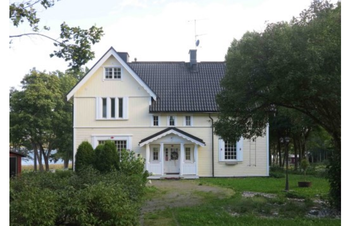
Lundabäck, f.d. Nybondas (124). Huvudbyggnaden företräder en villaarkitektur med intryck från det tidiga 1910-talets senjugendstil. Byggnaden har ett brant sadeltak med tvärställda gavlar. Huvudfasadens utformning representerar den i villaarkitekturen omhuldade s.k. cottage-typen. (A40)
