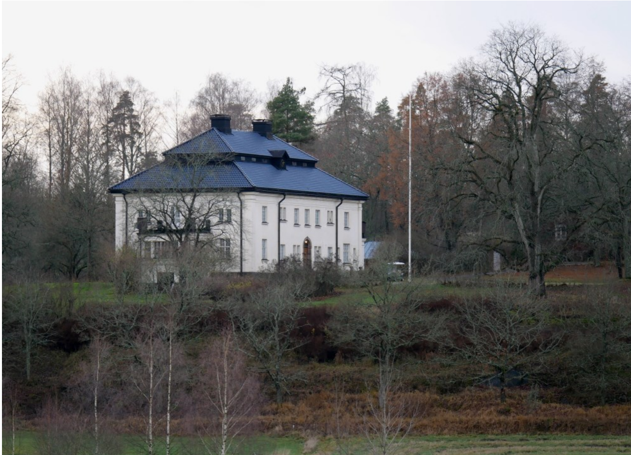
Kullo gårds karaktärsbyggnad (168) är en av de få herrgårdar i Nyland som har uppförts i början av 1900-talet på en gårdsplats från 1600-talet enligt ritningar av en arkitekt. Den år 1912–1914 uppförda vitrappade karaktärsbyggnaden i två våningar är ritad av arkitekt Carl Frankenhäuser.
