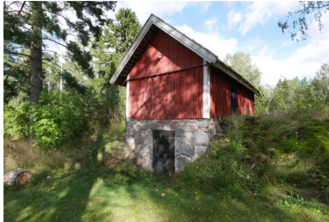
Källarbyggnad på Lindnäs (110).
