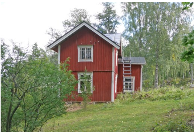
Lindnäs (110). Ett äldre boningshus i två våningar med sadeltak och en glasveranda på havssidan. Sockeln är av kilad sten. Fasaderna är klädda med äldre, rödfärgad lockläktpanel, fönstren har T-indelning.
