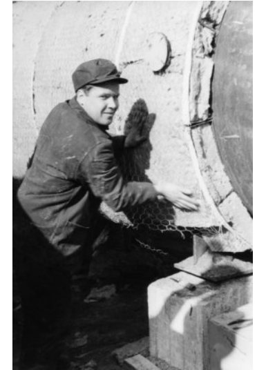
En arbetare isolerar en oljecistern på bygget i Sköldvik 1965. Työväen arkisto. finna.fi
