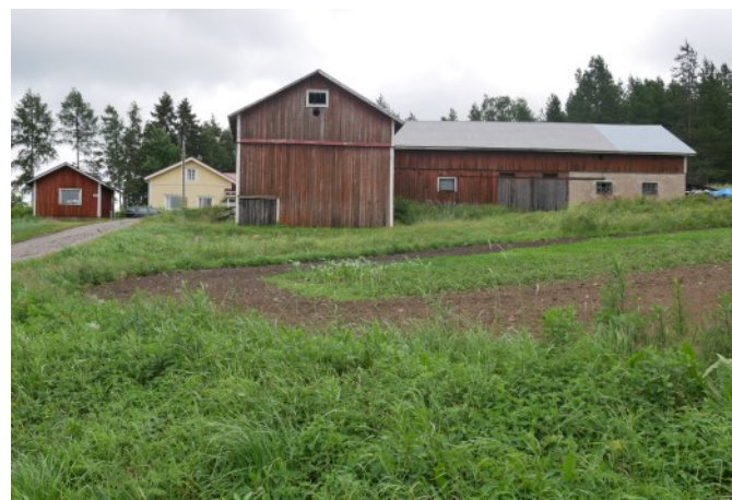
I Malmgårds (5) ladugård och ekonomibyggnad har olika material, cementmursten och träkonstruktioner, kombinerats på ett sätt som är typiskt för 1930-1950-talet.
