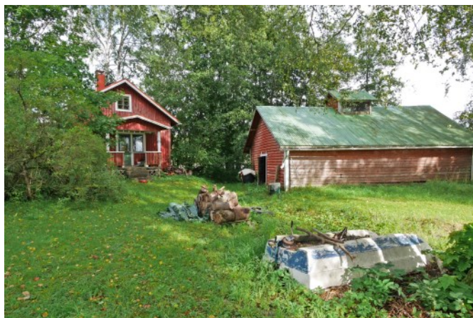
Till Vanha Huvilas (104) gårdsmiljö hör en villa med sockel av kilad sten, sadeltak och rödfärgad brädfodring med lockläkt. Fönstrens foderlister och den öppna förstukvisten har stildrag som är typiska för 1920-talet.
