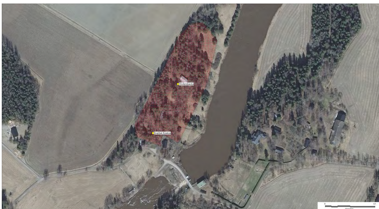
Flyfoto av objektet
