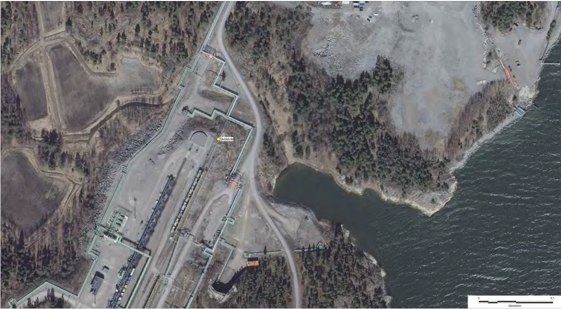
Flyfoto av objektet
