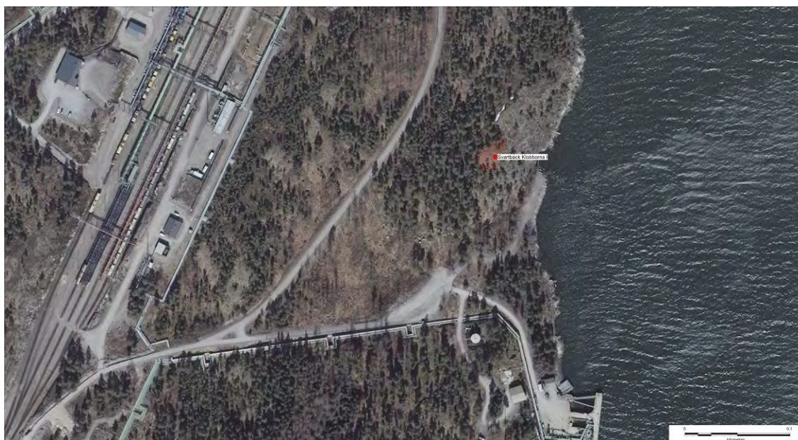
Flyfoto av objektet.
