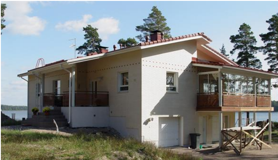
En modern egnahemsbyggnad i södra spetsen.
