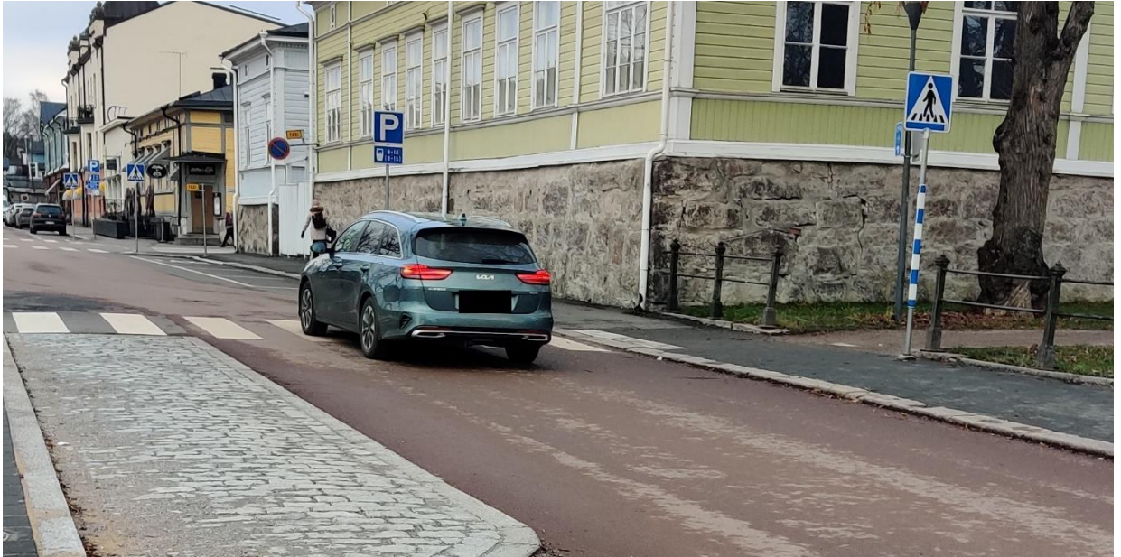
Kuva 3.24: Runeberginpuiston kohdalla Jokikadun ajorataan on rakennettu kavennus ja sivusiirtymä. Koska sivusiirtymä on loiva, moni pohjoiseen ajavista autonkuljettajista oikaisee paikassa keskeltä ajorataa. Moni etelään ajavista puolestaan oikaisee matalaksi rakennetun kiveyksen päältä.
