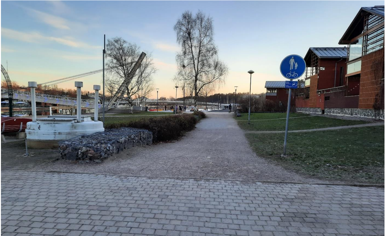
Kuva 2.5: Vuonna 2021 pyöräliikenteen pääreitit osuus Näse-Jutten kadun ja August Eklöfin puiston välillä oli kivituhkapintainen yhdistetty pyörätie- ja jalkakäytävä (kuva: Antero Eskelinen).
