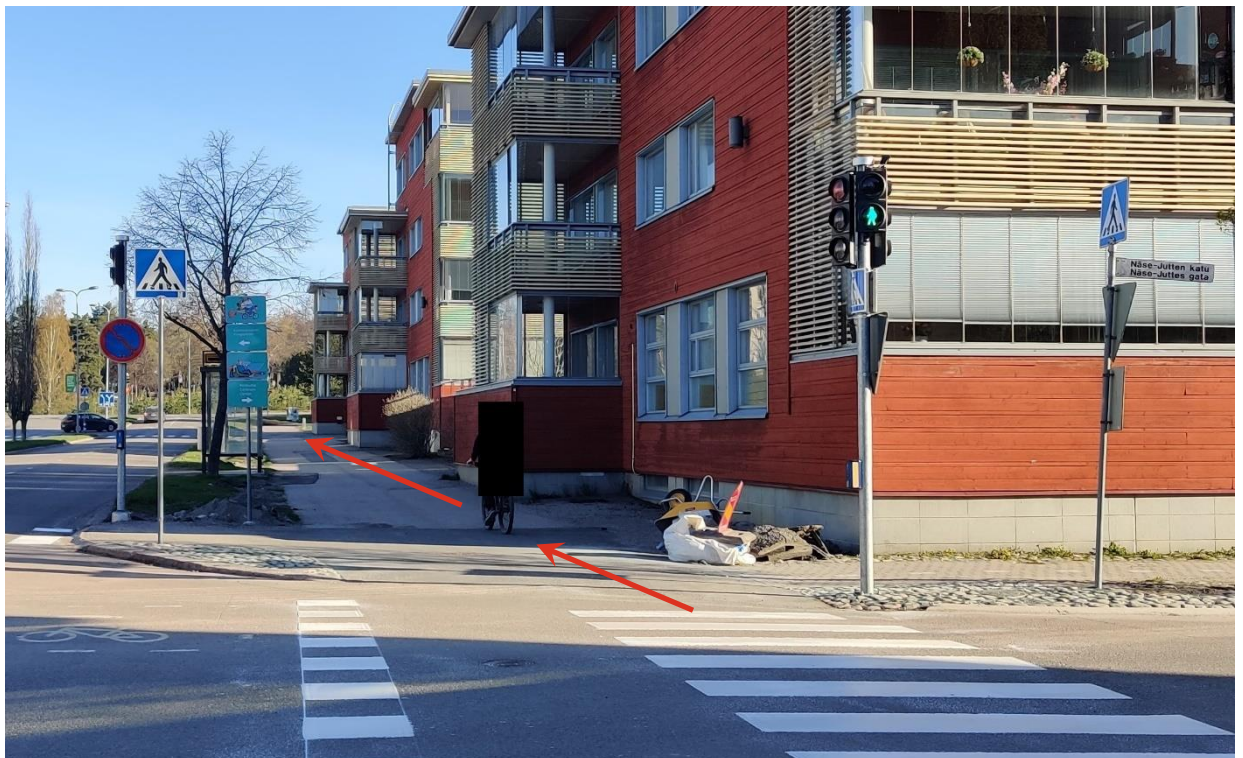
Kuva 3.35: Maunu Eerikinpojan kadun yhdistetyltä pyörätieltä ja jalkakäytävällä puuttuvat tarkoituksenmukaiset liikennemerkit. Väylällä on pyöräliikennettä siitä huolimatta.
