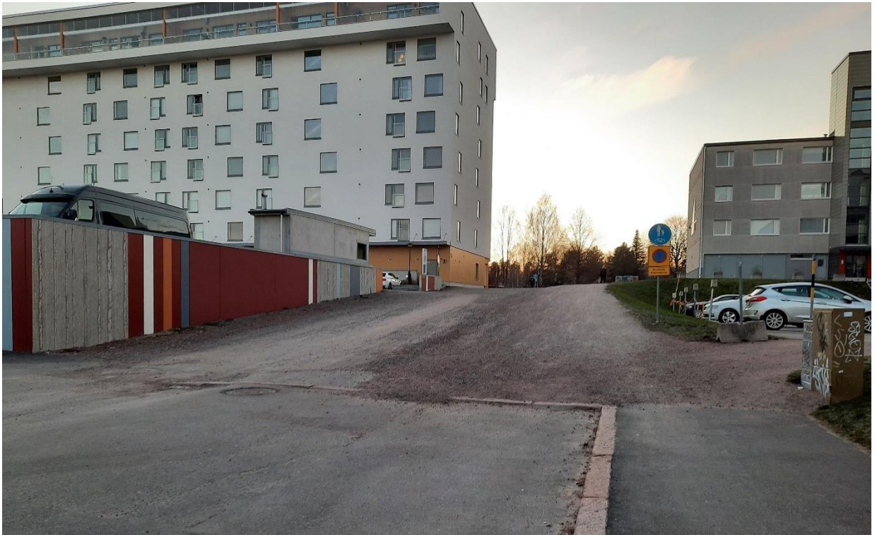
Kuva 2.3: Vuonna 2021 ennen kehittämishanketta Maistraatinkatu johti lännessä päällystämättömälle yhdistetylle pyörätielle ja jalkakäytävälle, ja kadunosien saumakohdassa oli reunakivi (kuva: Antero Eskelinen).
