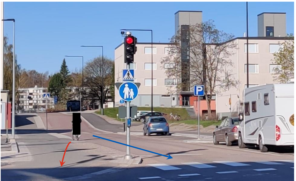
Kuva 3.32: Osa Maistraatinkadun pyöräliikenteestä siirtyy pyöräkadun ajoradalta jalkakäytävälle päivittäistavarakauppa Lidlin pysäköintialueen kohdalla olevan luiskatun reunakiven kautta.
