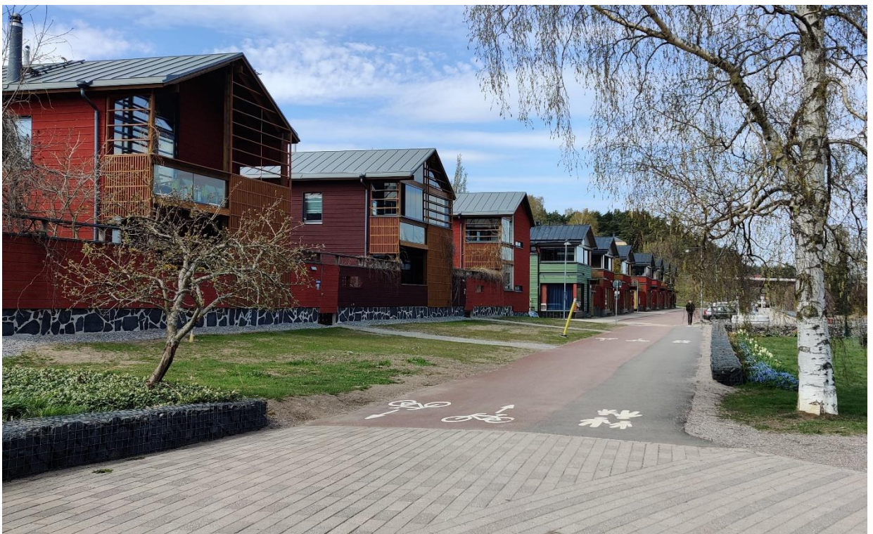
Kuva 2.11: Pyörätie ja jalkakäytävä rinnakkain August Eklöfin puiston ja Näse-Jutten kadun välillä (kuva: Tuomas Kiuru). Pyörätien puuttuva keskiviivan ja pyöräliikenteen jalankulusta erottavan reunaviivan tiemerkinnyt lisätään myöhemmin.
