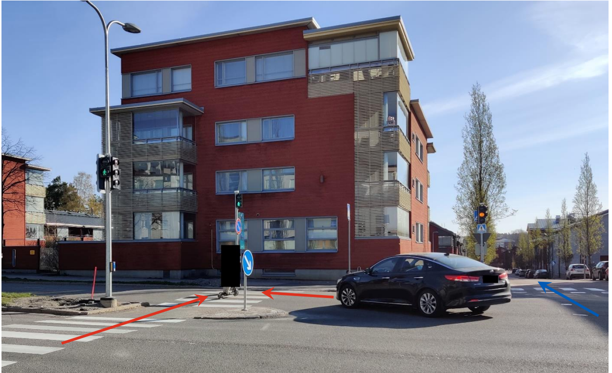
Kuva 3.37: Suojatien kautta kulkevan pyöräliikenteen ja kääntyvän autoliikenteen ajolinjat risteävät. Ajortaa pitkin ajaminen olisi sujuvampaa ja turvallisempaa, koska tällaista tilannetta ei syntyisi. Suojatien kautta todennäköisesti kuljetaan siksi, että suunnittelussa ei pitkään tunnistettu jalankulkua ja pyöräliikennettä omiksi erillisiksi kulkutavoikseen, jolloin ihmiset ovat tottuneet käyttämään jalankulun reittejä myös pyörällä (tai sähköpotkulaudalla) ajaessaan.
