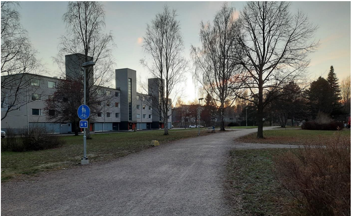
Kuva 2.4: Vuonna 2021 pyöräliikenteen pääreitien osuus Maistraatinkadun ja Näsin alikulkukäytävän välillä oli kivituhkapintainen yhdistetty pyörätie- ja jalkakäytävä (kuva: Antero Eskelinen).
