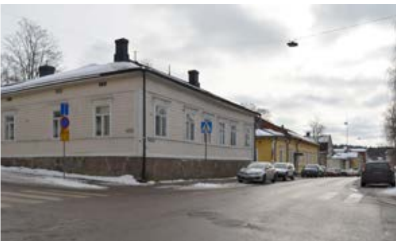
← Korttelin 31 katujulkisivu kohti Kaupungipuistoa on säilynyt yhtenäisessä empireasussa. Linnankoskenkadun kaupunkikuva on yhtenäisempi etelää kohti.
