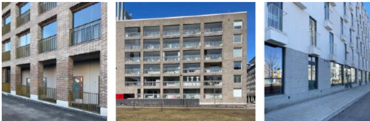
Bild 40 Till vänster och i mitten lätta balkongräcken på en inglasad balkong. Till höger en fördjupad fransk balkong. (NEMO arkitekthdit Oy)
