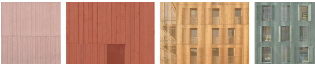
Bild 31 Vid dispositionen av träfasaderna kan olika överlappningar och panelbreddar användas.
