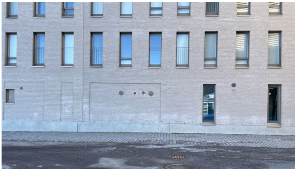
Bild 26 Exempelbildens fördjupningar i tegelmuren är inte tillräckliga och motsvarande lösningar godkänns inte.
