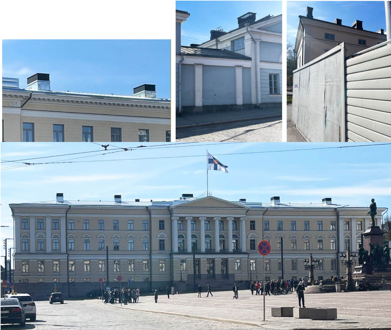
Bild 37 Referensbilder på reparationsobjekt, där den nya taktekniken har koncentrerats till visuellt enhetliga luftkanalsgrupper (NEMO arkitektdit Oy)
