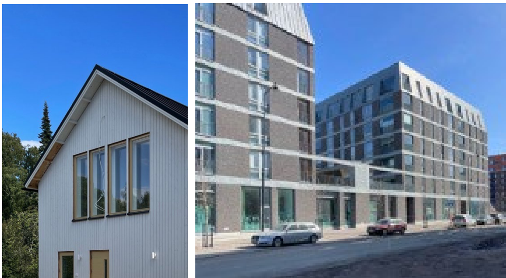
Bild 35 I träbyggnaderna ska det finnas ordentliga öppna takfötter. I byggnader med mansardtak är takbeloppet okonstlat förknippat med fasadytan. (NEMO arkkitehdit Oy)
