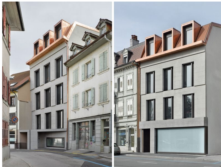
Bild 36 Alternativa takfönster: till vänster en taklykta och ett vertikalt fönster, i mitten dessutom ett takfönster med balkong, till höger ett vertikalt takfönster. Taket i referensbilderna har en annan takstruktur än husen på Borgå parkgata. (bilderna ovan: NEMO arkitekthdit Oy, bilder nedan: Boegli Kramp Arkitekthe)
