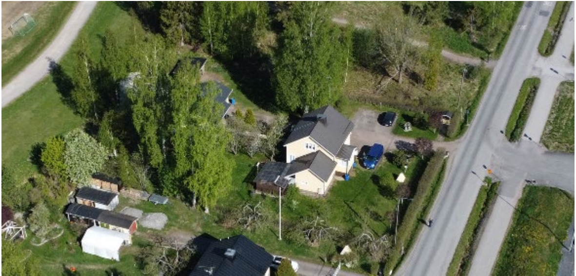
Kuva 7. Asemakaava-alueeseen sisältyvä osoitteessa Lapinniementie 32 sijaitseva pien- talokiinteistö viistoilmakuvassa kaakosta. Kuva 24.5.2022.
