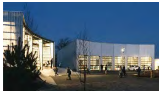
JULKISIVU JA VALAISTUS, KYLMÄT KATETUT TILAT
