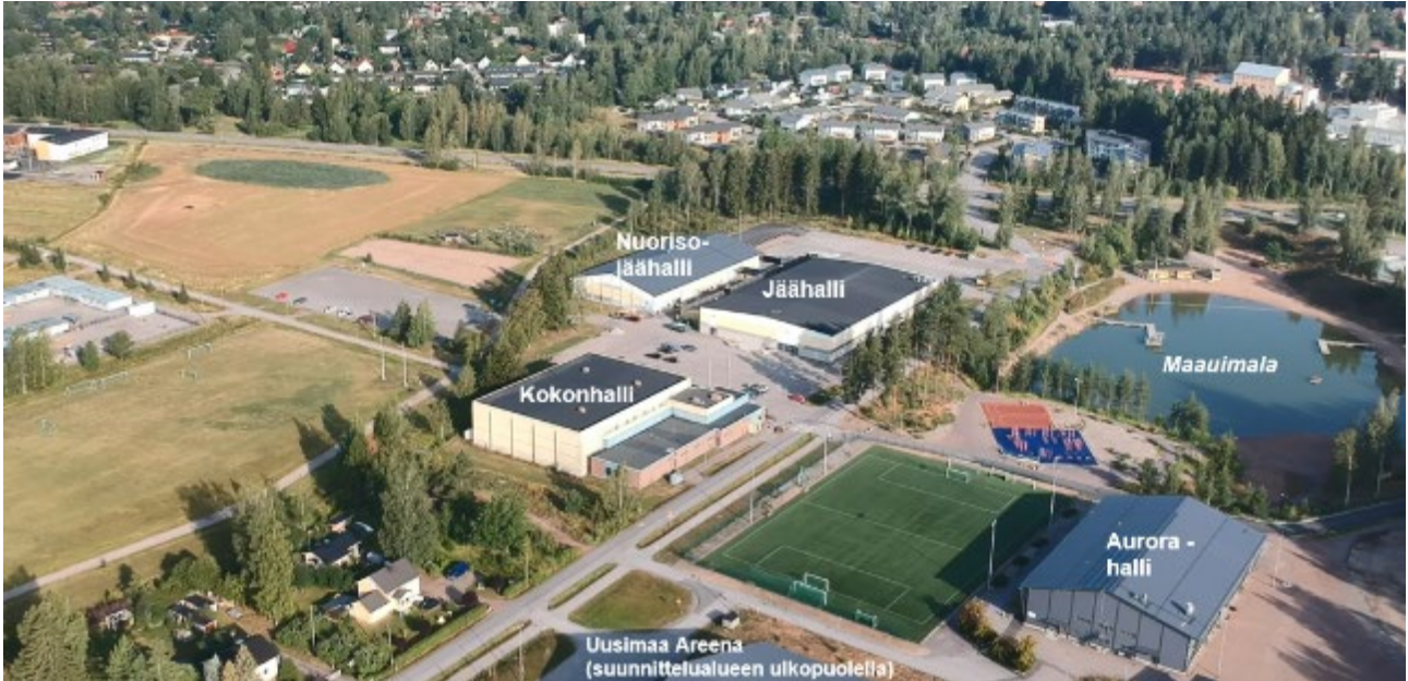
Kuva 4. Alueen rakennuskanta ilmakuvasa selittävin tekstein. Ilmakuva, ote videosta 8.8.2019.
