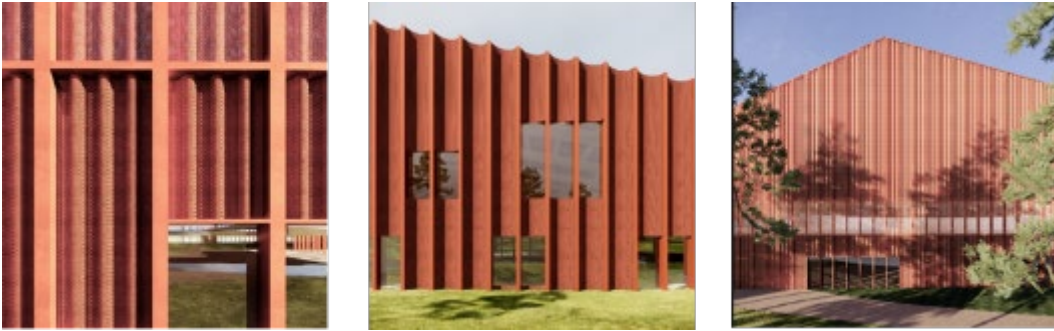
Bild 3. Skuggorna skapar djup i byggnadens fasad (Schauman Nordgren Architects). Fasaderna formas genom att lägga till ytstrukturer med varierande djup för att ge den stora byggnadsmassa ett livfullare utseende.
