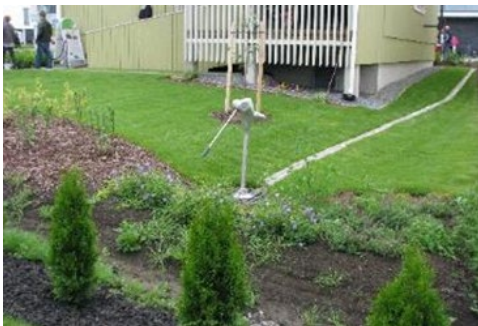
Kuva 6. Vesi on johdettu maanalaiseen säiliöön pihapinnalta betonikivisellä kourulla ja katolta sadevesirännin kautta maanalaisella putkella. Vettä saa nostettua sadevesisäiliöstä käsipumpulla.
