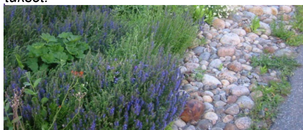
Kuva 16. Pihikäytävän ja pysäköintipaikan reunalla on imeytysalueen pintana mukulakiviä ja perennaistutus. Imeytys kastelee istutukset.
