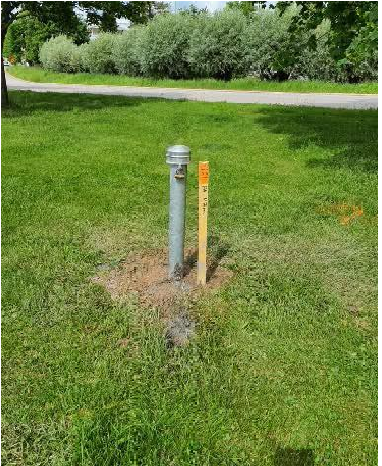
Valokuva putkesta (asennuksen jälkeen)
