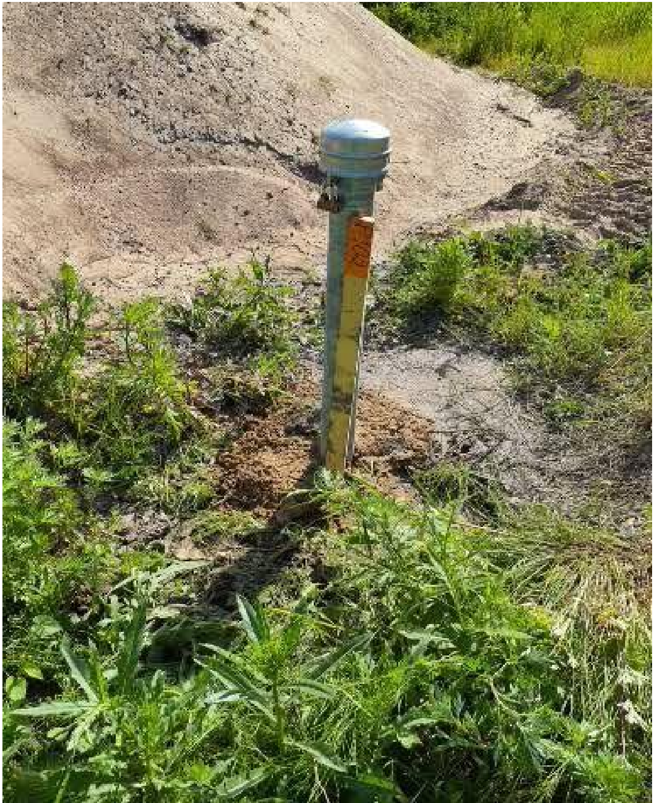
Valokuva putkesta (asennuksen jälkeen)
