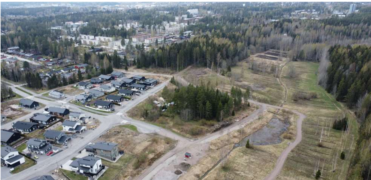
Kuva: Kopterikuva etelästä päin. Kaava-alueella on laaksossa metsittyviä peltoja ja viljelypalsta-alue. Kevätlaakson jo rakennetulla alueella on ojan varteen muotoiltu hulevesitulvia tasaava lampi.
