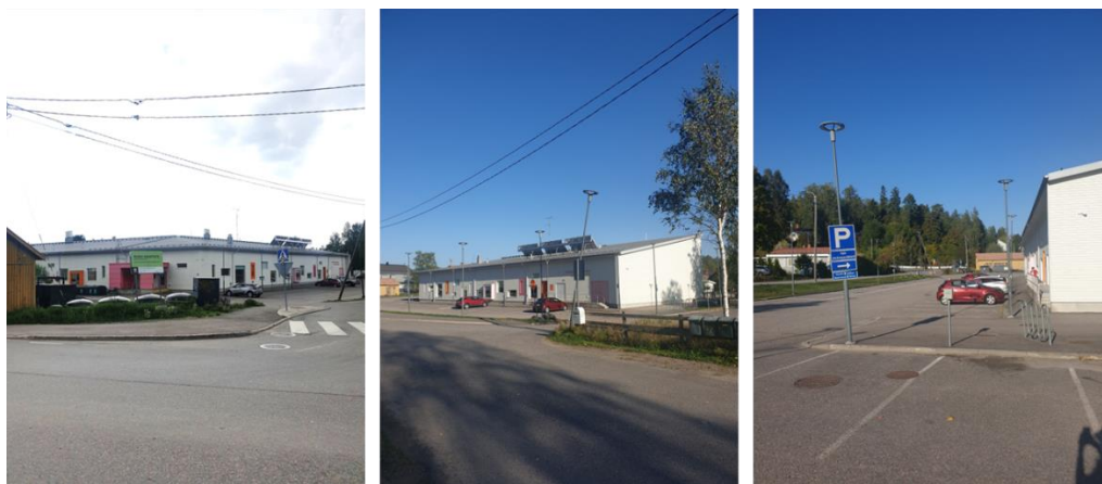
Bild 5. Daghemsbyggnad sedd från vägen och dess parkeringsområde
