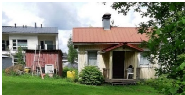
Bild 10. Väl bevarad bastubyggnad.
