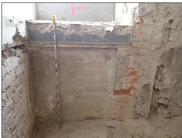
Vuorikadulle avautuva ulko-ovi koillissiiven pohjoisnurkassa. Kadun pinta on n. 110 cm mitan alla olevaa purkamatonta betonilattiaa korkeammalla.
