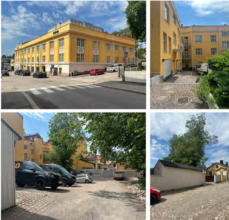
Valtimontalo, nykyinen hotelli Runo. Piha on osittain kivettyä ja osittain kivituhkaa. Vuorikadun varrella on pienehkö uusi jätekatoksena toimiva rakennus.
