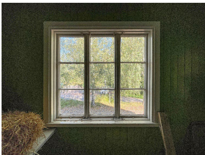
Bild 24. Fönstret i vindskyddet vid den nordöstra gaveln är ett originalfönster av trä som öppnas både inåt och utåt. Vindskyddets väggar är klädda med grönmalade vertikala paneler.
