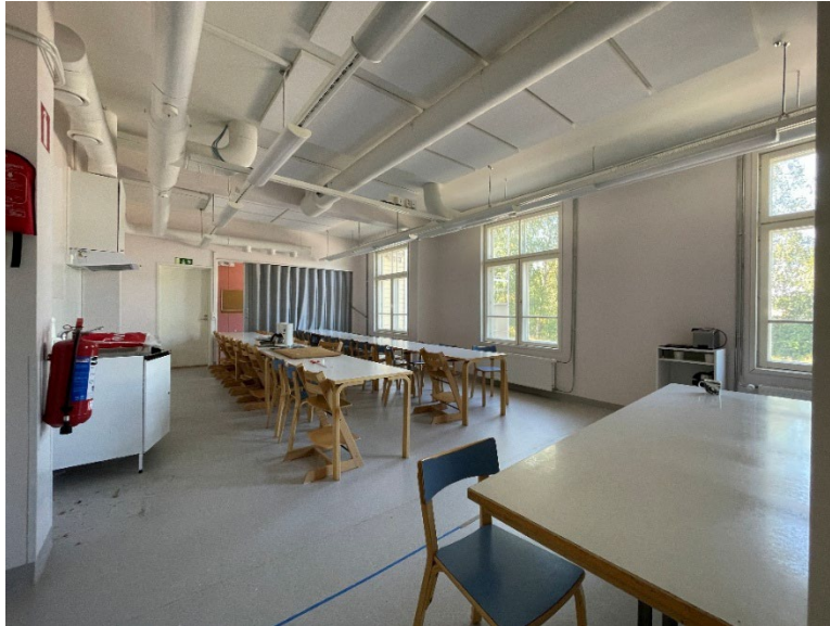
Kuva 23. Näkymä sisätiloista nykytilassa. Lattialla on harmaa muovimatto ja alakatossa on talotekniikkaa ja akustiikkapaneeleja. Ikkunat on uusittu.
