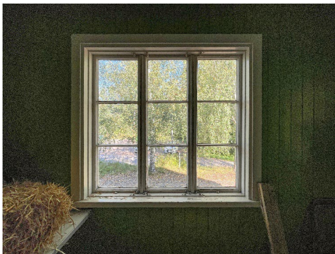
Kuva 24. Koillispäädyn tuulikaapin ikkuna on alkuperäinen sisään-ulos-aukeava puuikkuna. Tuulikaapin seinät on paneloitu vihreäksi maalatulla pystysuuntaisella paneelilla.
