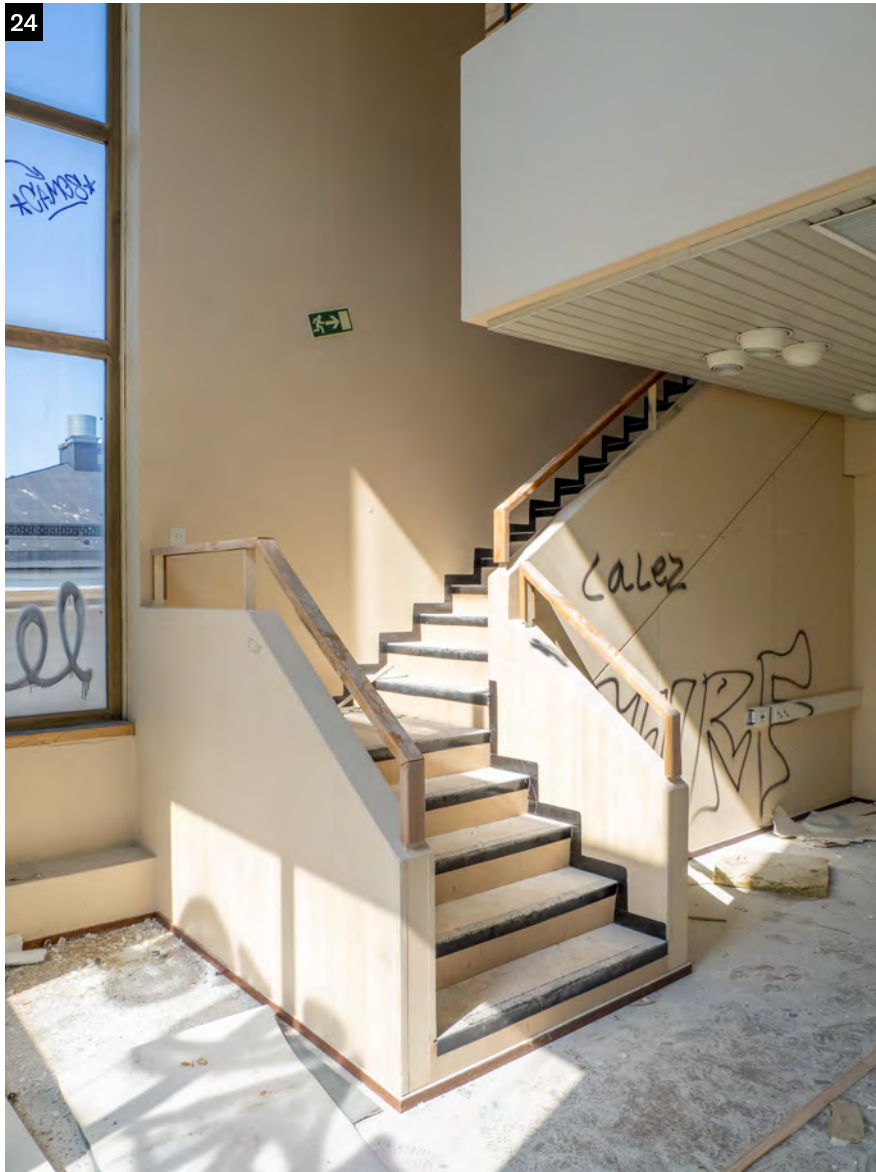
↑ Vanhan kirjaston länsipäätyyn rakennettiin erillinen porras, joka nousee kolmannen kerroksen parvelle. Ratkaisu tuo vanhaan kirjastosaliin julkisen tilan tuntua.
