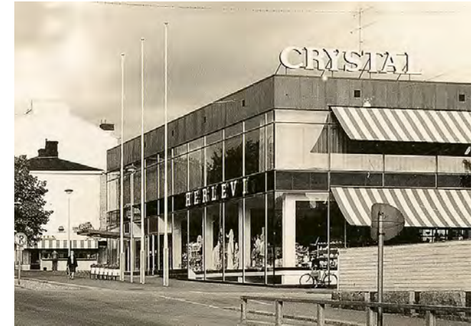
↑ Lindroosit suunnittelivat Porvooseen myös Herlevin liiketalon, joka valmistui vuonna 1960. Runeberginkatu 33:ssa sijainnut rakennus on sittemmin purettu nykyisen K-citymarketin tieltä. Porvoon museo.
