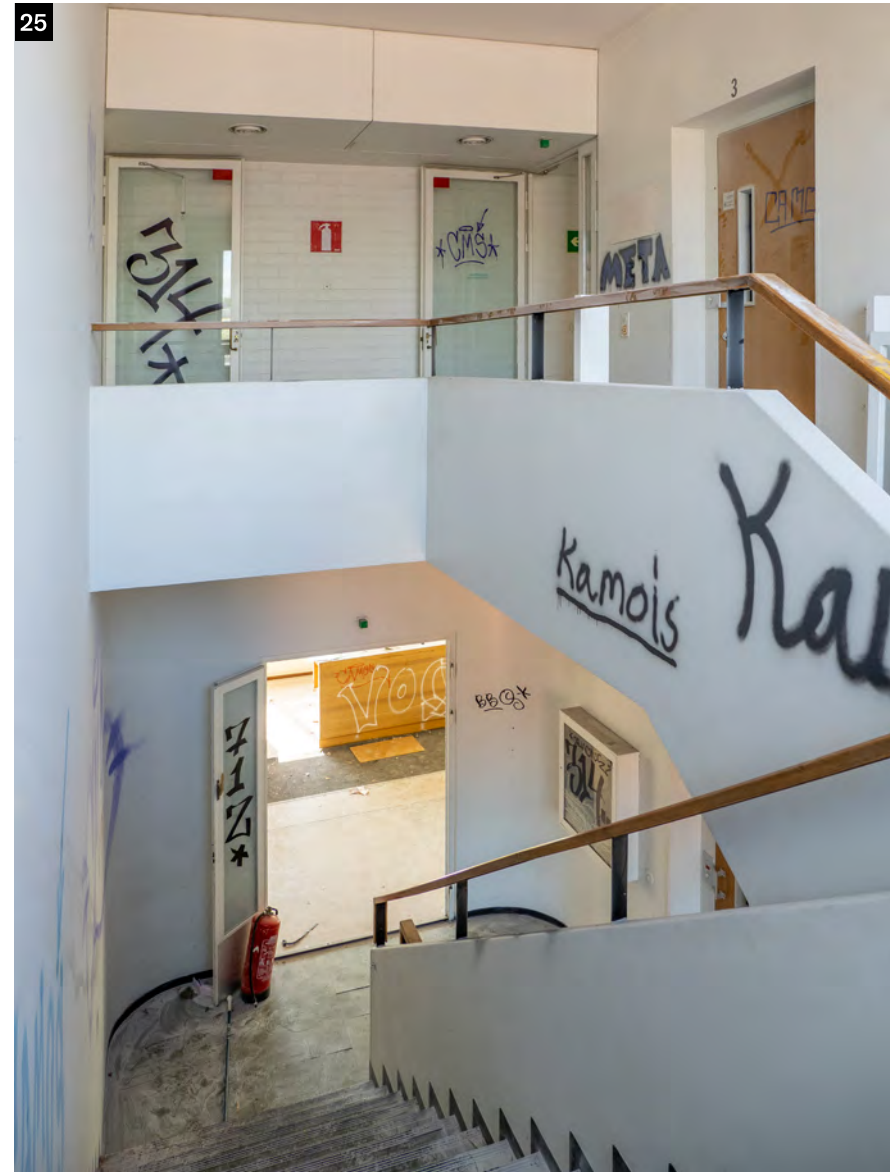
↑ 1970-luvulla rakennetun uuden pääportaan yhteyteen tehtiin myös hissi. Uuteen pääportaaseen käytiin sisään Mannerheiminkadulta uuden sisäänkäynnin kautta. Porrashuoneen toisen kerroksen tasanne erottuu pyöristetyllä kulmamuodollaan.
