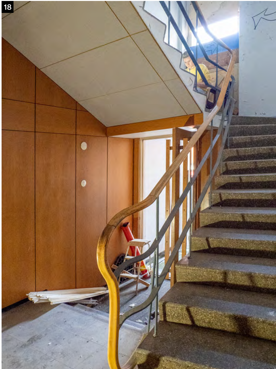
↑ Vanhan porrashuoneen seinät on pohjakerroksen tasolla verhottu uusien puupaneelien. Alun perin rakennuksen ainoa porras on saanut 1970-luvun muutosvaiheen myötä toisarvoisen luonteen, kun Mannerheiminkadun puoleiset julkiset tilat yhdistettiin uudella pääportaalla. Portaan alkuperäinen käsijohde on tyylitelty pyörästetyin muodoin alapäästään.
