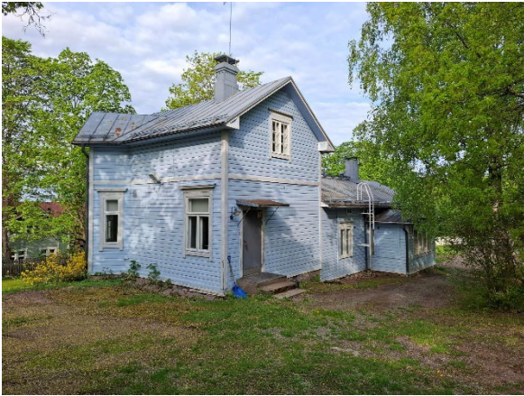
Kuva 20. Sininen päiväkotirakennus idästä, laajennusosan puolelta.
