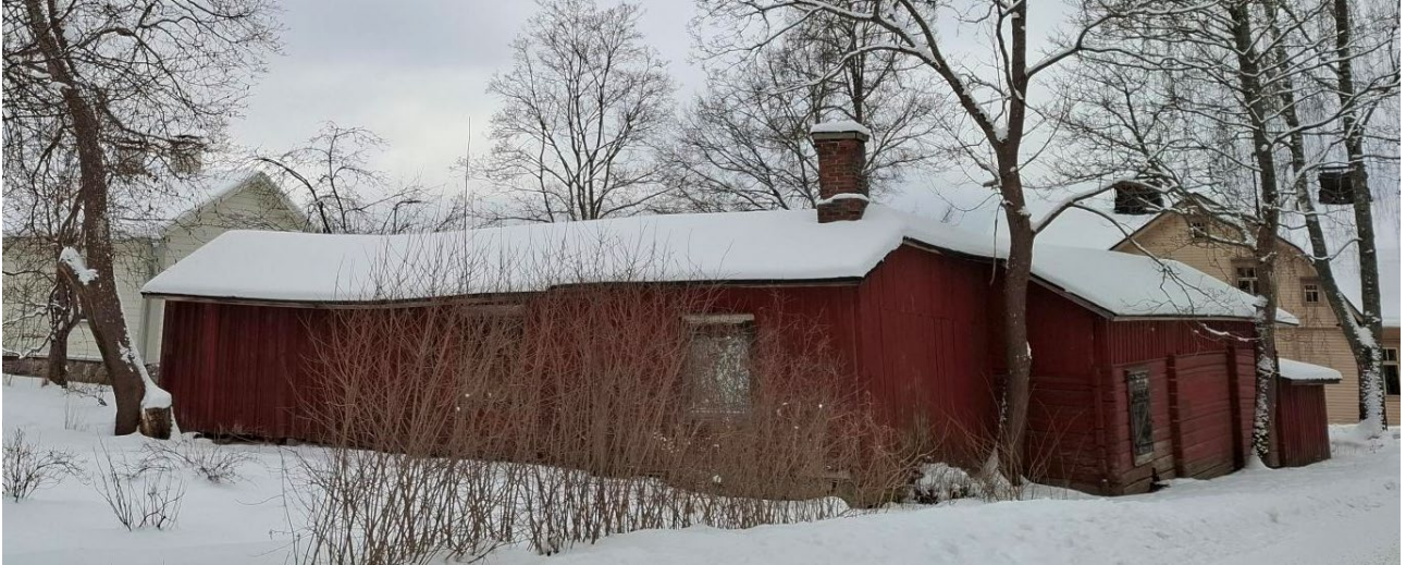
Kuva 33. Sivurakennuksen pohjois- ja itäjulkisivut Kanttorintieltä kuvattuina.
