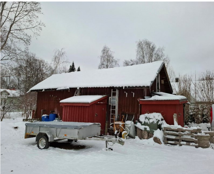
Kuva 11. Sivurakennuksen julkisivu länteen, pihan suuntaan.
