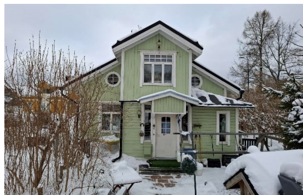
Kuva 8. Julkisivu pihalle. Yläkerran ikkuna on jugendtyylinen, katon lappeen alla on pyöreät ikkunat ja alakerrassa t-ikkuna sekä uudempi kapea korkea ikkuna.
