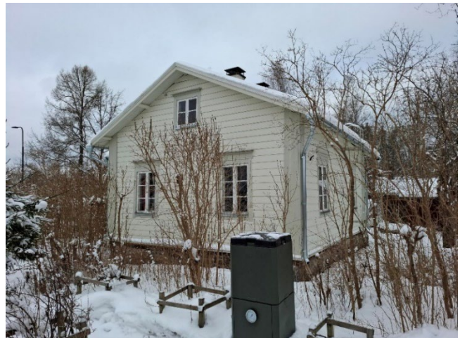
Kuva 7. Julkisivu etelään, naapurin pihalta kuvattuna.
