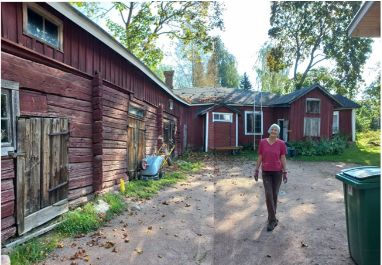
Kuva 32. Kuvayhdistelmä Sivurakennuksen julkisivut pihan puolelle.
