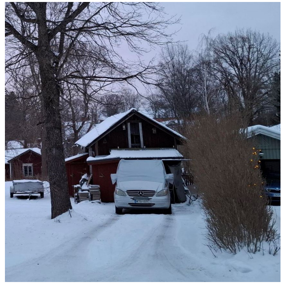
Kuva 12. Sivurakennuksen julkisivu etelään, Tynnyrintekijänmäen suuntaan.
