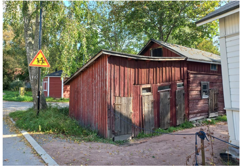
Kuva 31. Lautarakenteisessa osassa on ulkokäymälöiden rakenteet jäljellä. Kadun varrelle rakennettiin uusi ulkoseinä, jotta tyhjennys voitiin tehdä piilossa katseilta.
