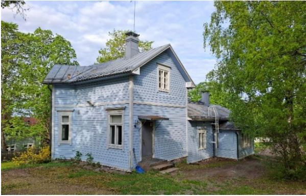
Bild 20. Den blåa daghemsbyggnaden i riktning från öster, från utbyggnadsdelen.
