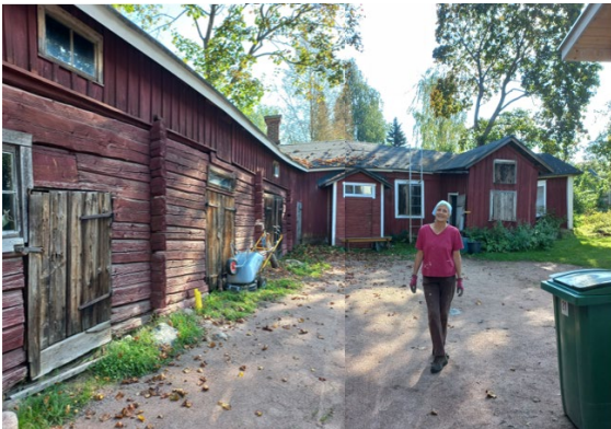
Bild 16. Nr 23, huvudfasaden och en del av gavelfasaden mot Gamla Kungsvägen.
