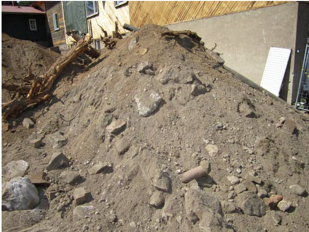
Kuva 7. Rakennuksen ympärystäyttoa.
