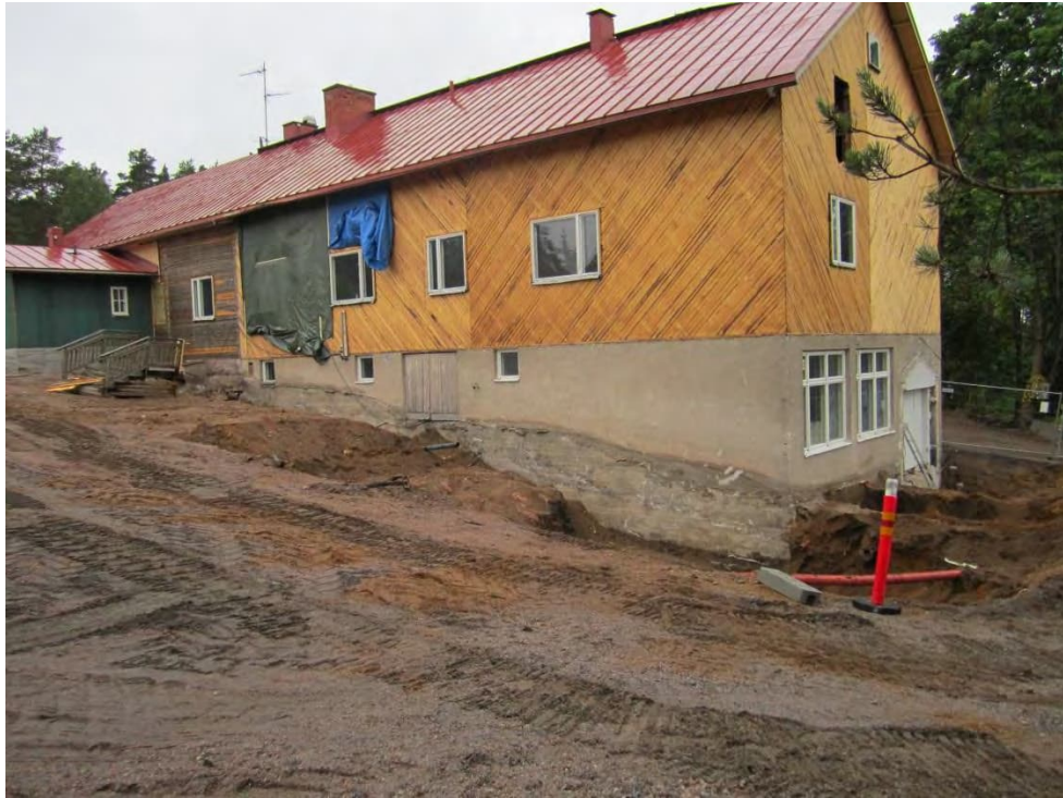
Kuva 1. Suomenkylän koulu maatöiden alkuvaiheessa.
