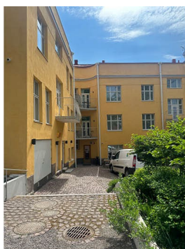
Valtimohuset, nuvarande hotell Runo. Gården är delvis stenbelagd och delvis av stenmjöl. Längs Berggatan finns en liten ny byggnad som fungerar som avfallstak.
