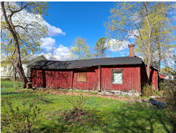
Kuva 17. Kievariosa on hyvin huonossa kunnossa. Leivintuvalla on korkeampi kivistä ladottu sokkeli ja yksiruutuinen lasi-ikkuna.
