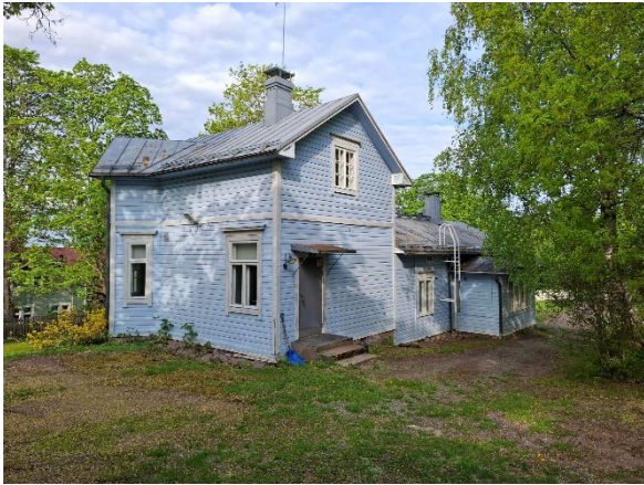
Kuva 19. Sininen päiväkotirakennus idästä, laajennusosan puolelta.
