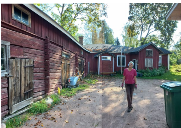
Bild 15. Den del där gästgiveriet fanns är i mycket dåligt skick. Bagarstugan har en högre sockel staplad av sten och ett fönster med en glastruta.
