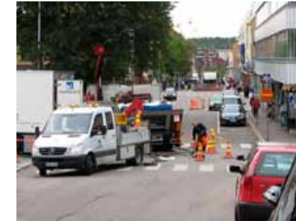
Lundagatans avlopp saneras med infodringsteknik
