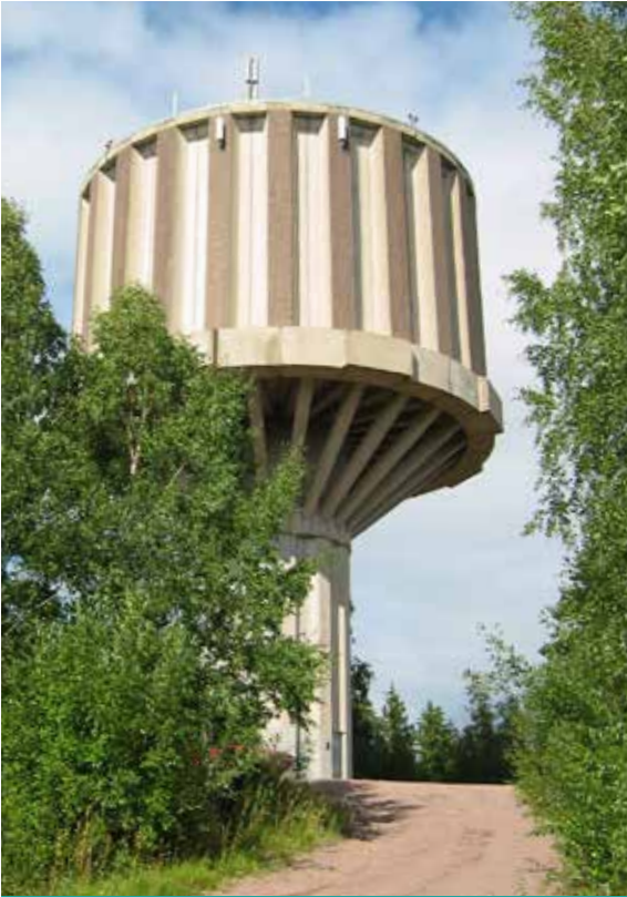
Hamarin vesitoria joudutaan vahvistamaan, koska vastaavanlainen vesitorni romahti Jyväskylän Kangasvuorella syksyllä 2012. Korjauksen ansiosta torni saa noin 50 vuotta lisäaikaa. Sen ulkonäkö ei oleellisesti muutu. Förstärkningen och renoveringen av Hammars vattentorn aktualiserades när ett motsvarande vattentorn kollapsade i Jyväskylä hösten 2012. Renoveringen förlänger vattentornets brukstid med cirka 50 år. Tornets utseende förändras inte.
