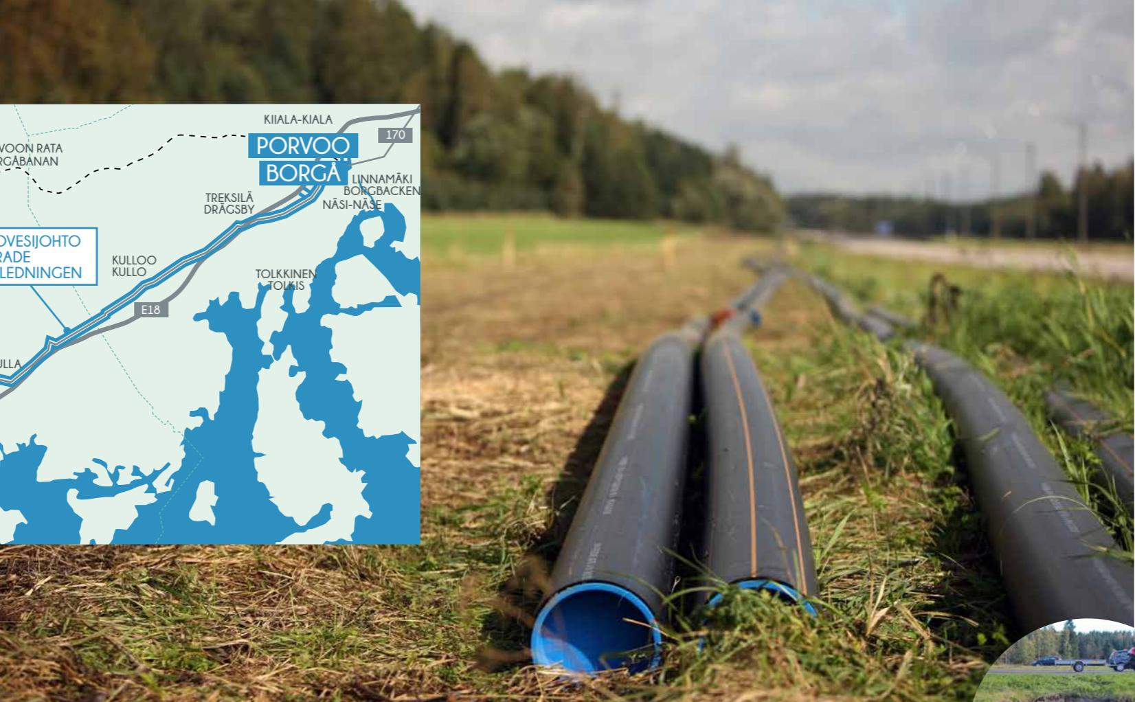
Siirtovesijohto sijoitetaan suurimmaksi osaksi maantien 170 varteen. Transportvattenledningen löper huvudsakligen längs väg 170.
