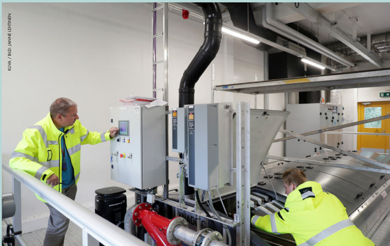
Kiekkosuodattimia on kaksi identtistä yksikköä. Kiekot pyörivät jatkuvatoimisesti, käyttöinsinööri Martin Alm kertoo. Mukana kuvassa puhdistamohoitaja Johan Öhberg. Skivfiltreringsanläggningen består av två kontinuerligt roterande identiska enheter, säger driftingenjör Martin Alm som flankeras av medarbetare Johan Öberg.
