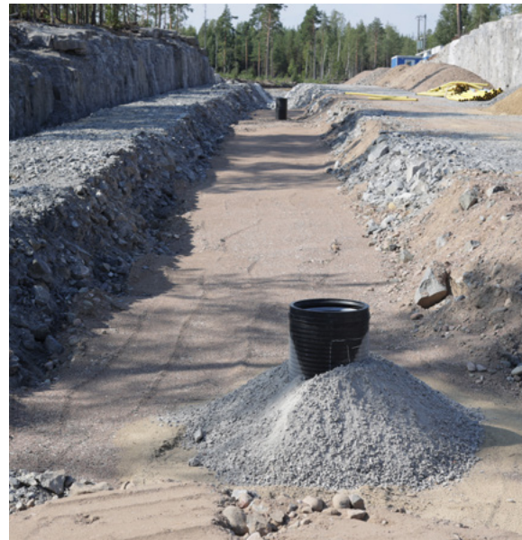
→ Työmaa vaiheessa: täytetty vesihuoltokaivanto ja rakenteilla oleva katu.
