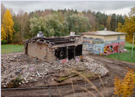
Tältä näytti Linnamäen vesilaitos viime syksynä. Så här såg Borgbackens vattenverk ut på hösten.
