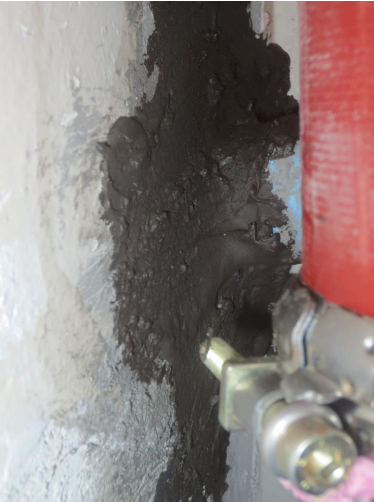
Kuva 1. Tekniikkakotelon sisällä olevan putkiläpiviennissä havaittiin ilmapuotoja.
