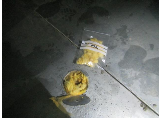
Kuva 3. Näytteet kerättiin poraamalla kanavan peltiseinämään reikä.
